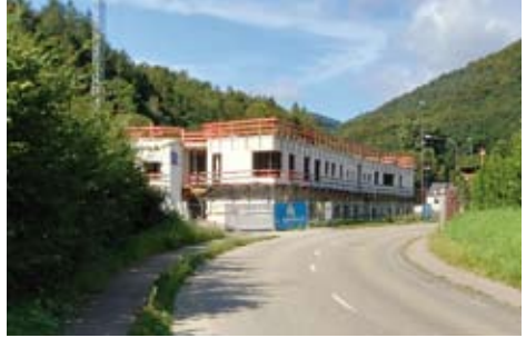
14. 9. 2023: Der Rohbau ist fertig!
